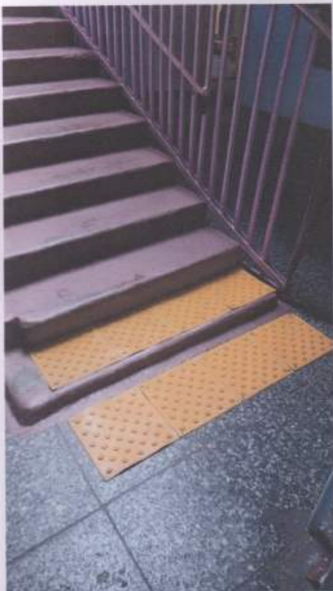
Рис 3 Сигнальная притивоскользкая лента
